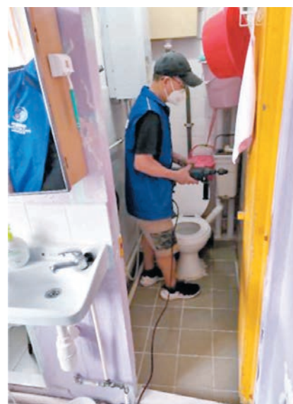
◆鴨洲邨關愛隊義工，為邨內高齡長者及有需要住戶在浴室安裝扶手
