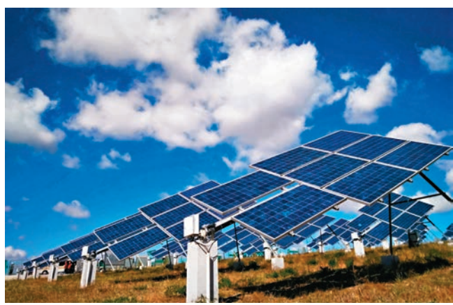
◆香港應積極與內地合作開發更多樣化的綠色金融產品。圖為內地光伏發電場。
